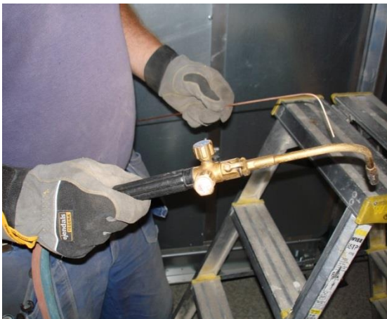
Bild 1. Utrustning för lödning av kopparrör
