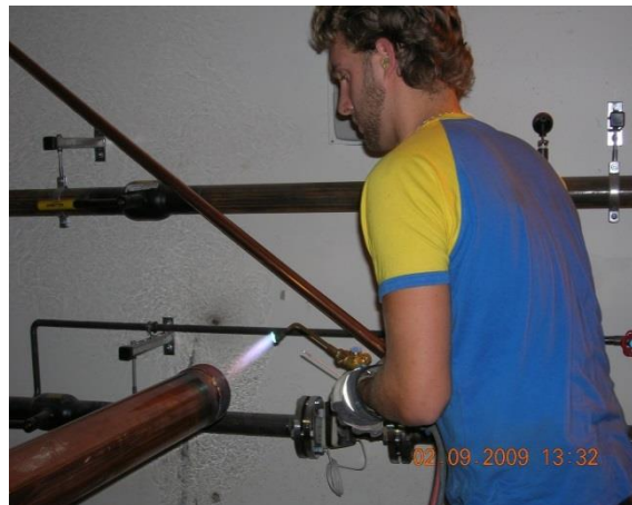
Bild 2. Lödning vid arbetsbänk
