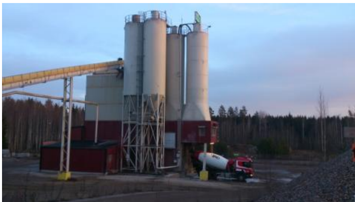
Foto: En anläggning för tillverkning av fabriksbetong
