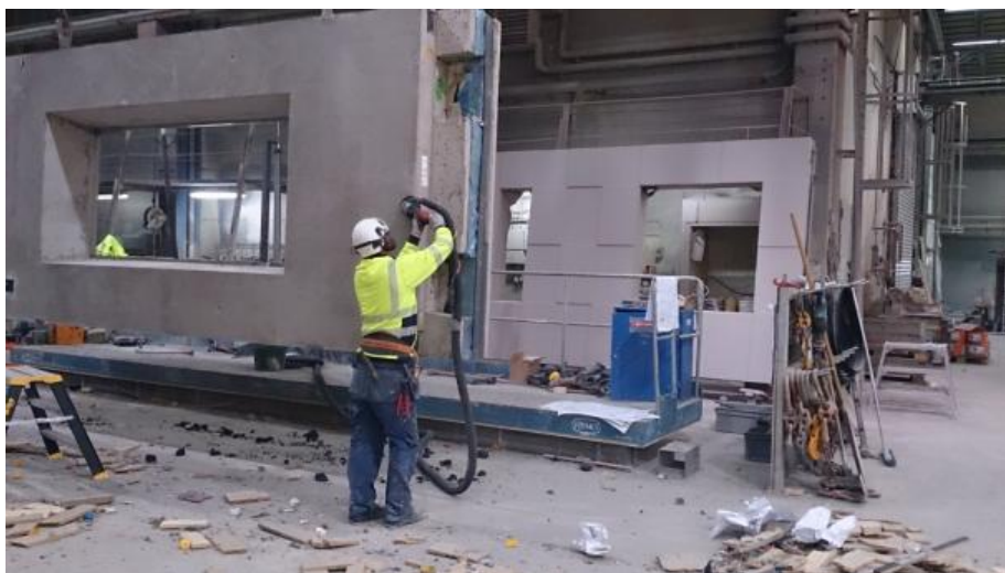
Foto: Slipning av betongelement på betongvarufabrik. Slipmaskinen försedd med integrerat utsug.
