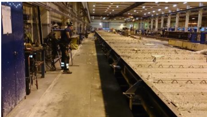
Foto: Tillverkning av betongelement
