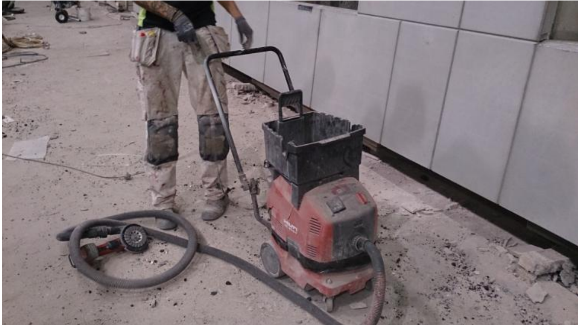
Bild 1. Slipmaskin med integrerat utsug, anslutet via slang till en mobil vacuumenhet.
