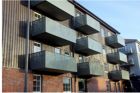
Figur 9. Foto från husen på Majstångsgatan i Majorna. Foto: Krister Engström
